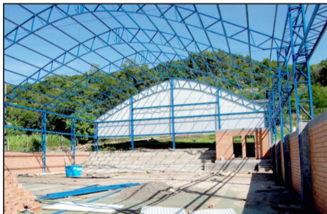
Serviços de cobertura em ritmo forte
