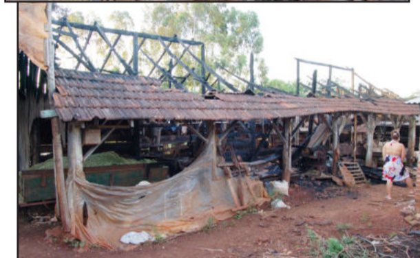
Incêndio destruiu galpão e implementos das famílias Thies e Schmidt
