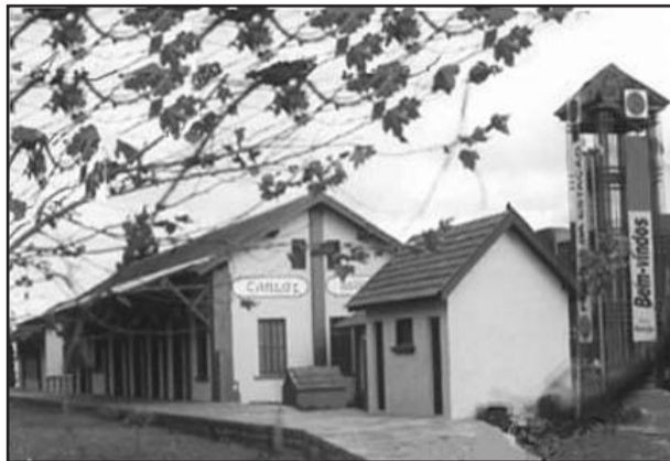
Casa do Artesão de Carlos Barbosa está localizado em estrutura da Praça da Estação
