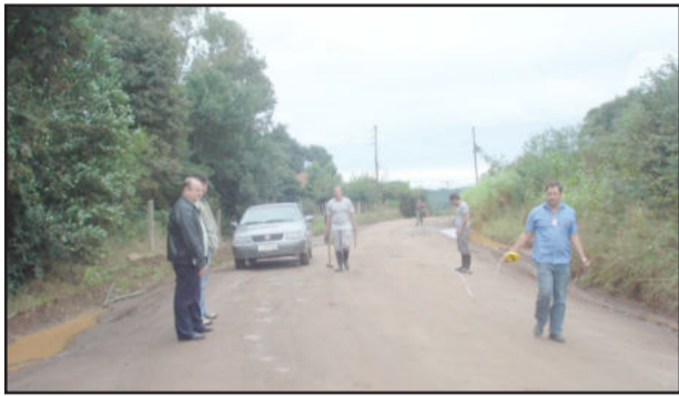
Dickel acompanhou início dos trabalhos de asfaltamento da estrada
