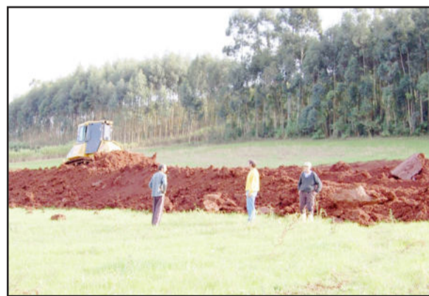
Serviço de terraplanagem na Linha Boa Vista 37
