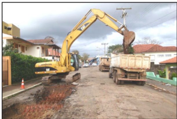
Camada danificada esta sendo removida
