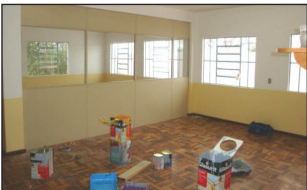
Nova sala foi construída
