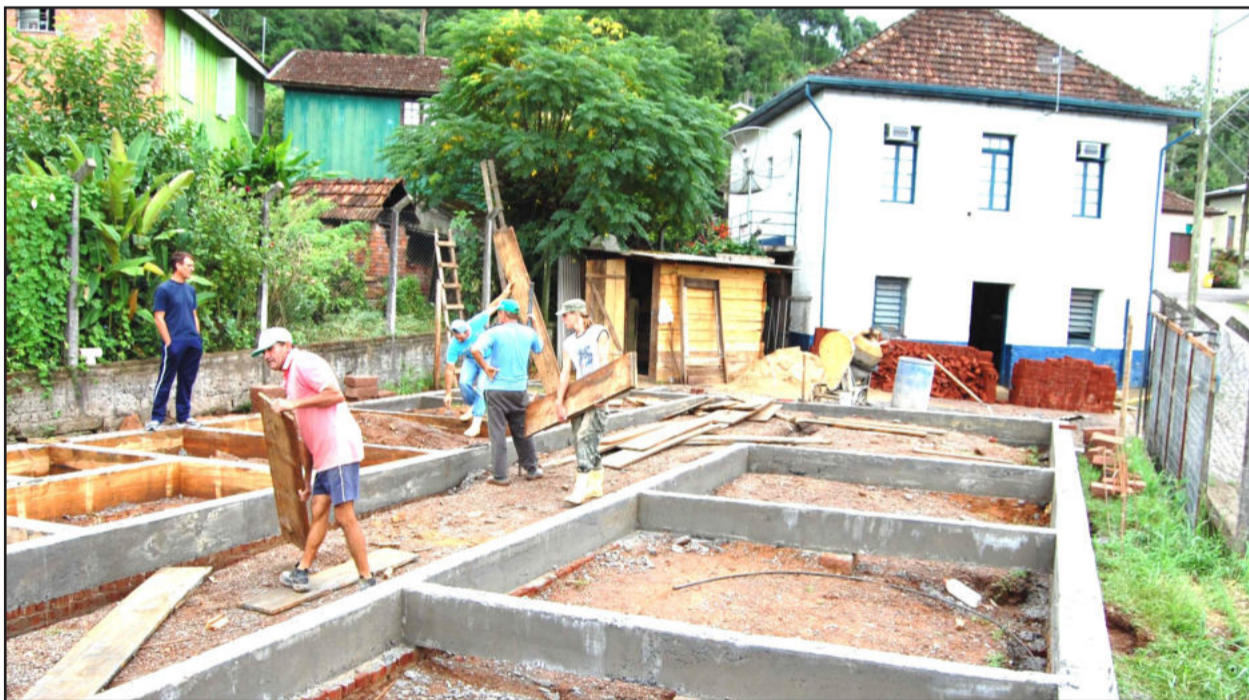
Obra da nova Unidade de Saúde de Daltro Filho
