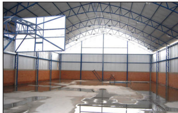
Quadra de escola recebeu cobertura
