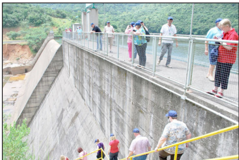
Grupo conheceu a barragem da hidrelétrica
