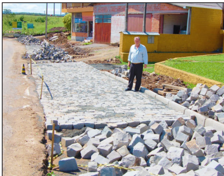
Prefeito acompanha execução das obras no acostamento da VRS-835
