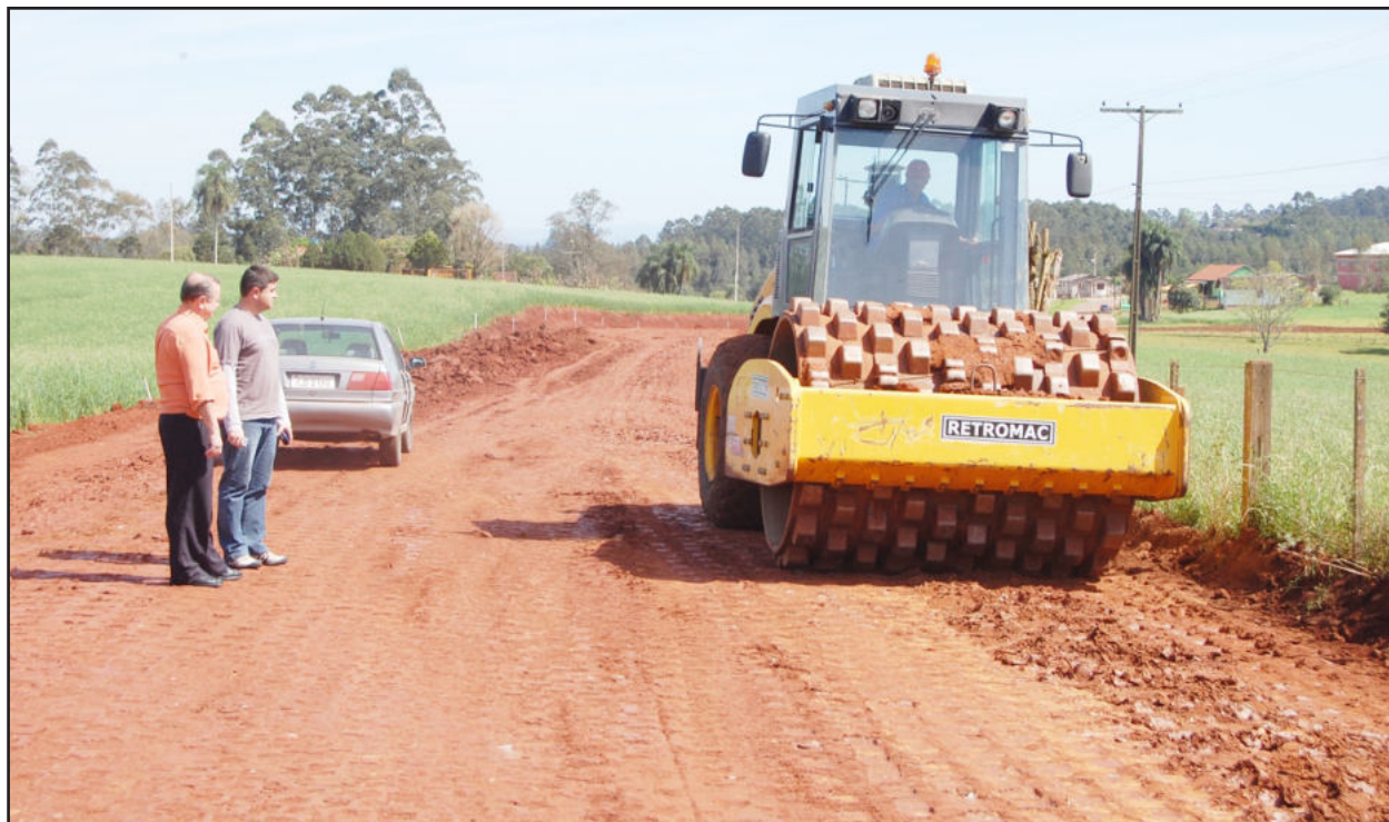
Prefeito e engenheiro acompanham as obras da estrada
