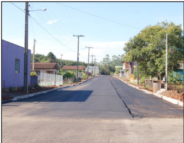
Rua 15 de Novembro também está com trechos finalizados e parte por concluir
