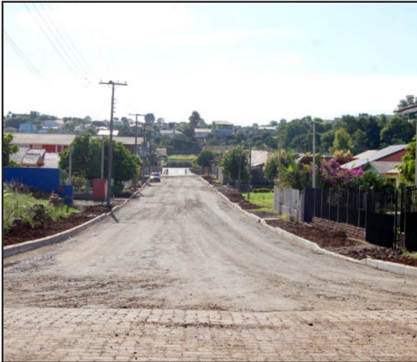
Rua João Musskopf em Canabarro deve receber a capa final de asfalto nos próximos dias
