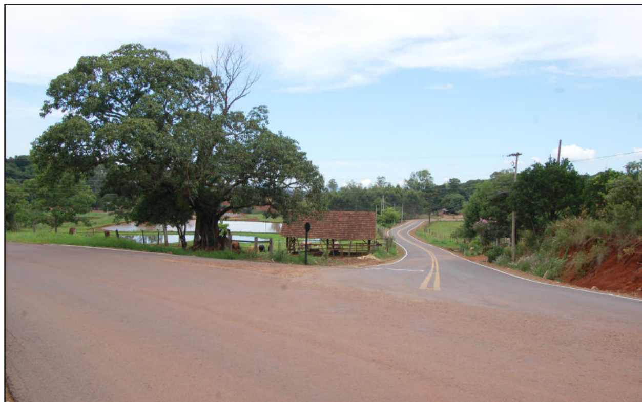
Estrada de Linha Ribeiro se conecta na via para Linha Wink na Estação Figueira
