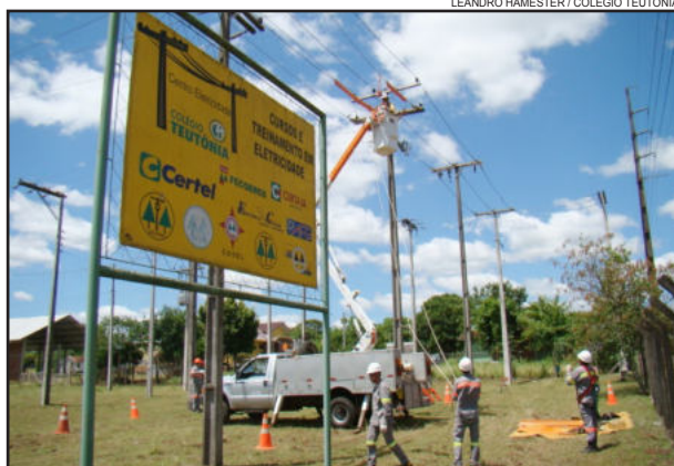
Colégio Teutônia conta com Centro de Treinamento em Eletricidade para atender necessidades estruturais da nova formação profissionalizante
