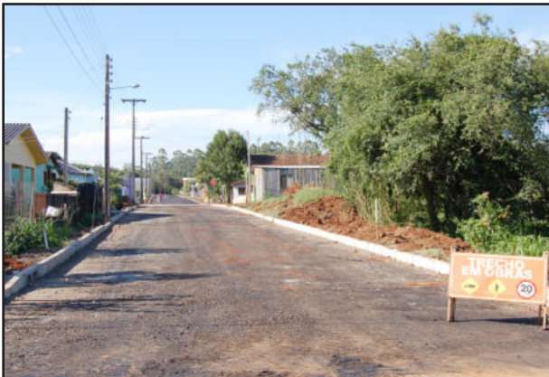
Rua 15 de Novembro também está com trechos finalizados e parte por concluir
