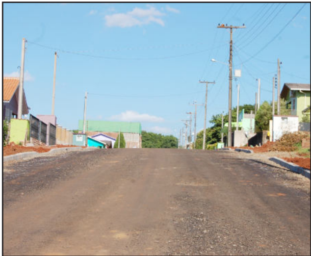
Rua João Musskopf em Canabarro deve receber a capa final de asfalto nos próximos dias
