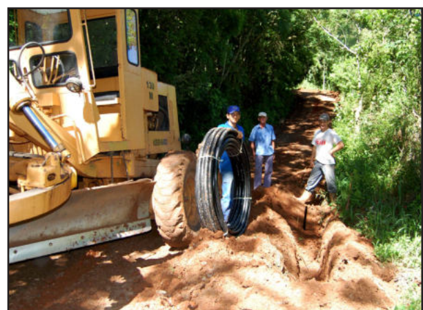
Colocação de tubos na rede de água de Linha Herval
