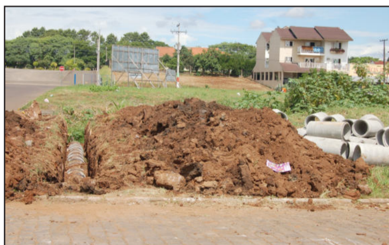
Nova canalização melhorará escoamento de água na Rua 2 Leste
