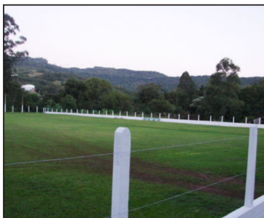
Obras do campo estão praticamente concluídas
