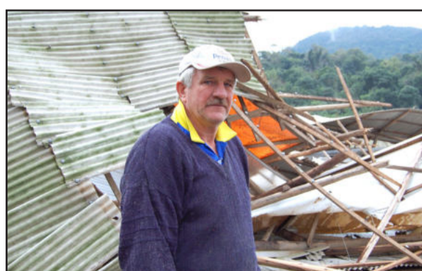
Hilário Stevens estava desolado com a destruição
