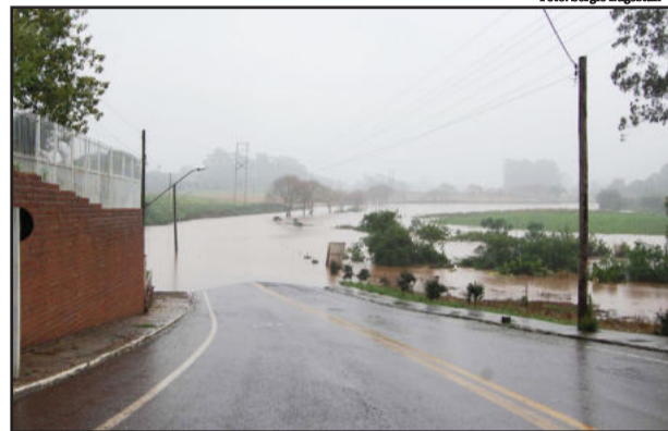
Rio Taquari interrompeu a rodovia
