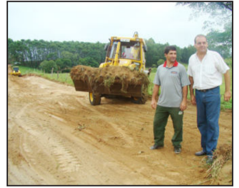
Secretário da Agricultura, Vanderlei Schweitzer, com o vice-prefeito, João Fernandes, nas obras da Rua Alvorada
