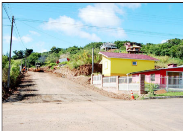
Trecho em pavimentação na Rua Augusto Gärtner
