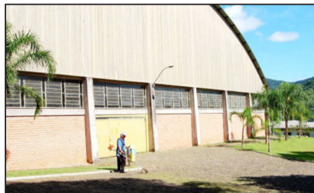
Área externa do ginásio recebeu limpeza e roçadas
