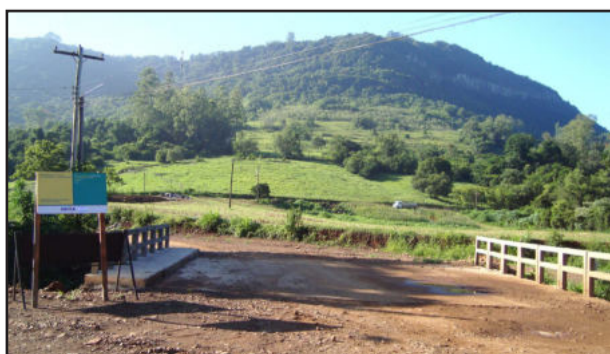
Ponte recuperada sobre o Arroio Rosenthal
