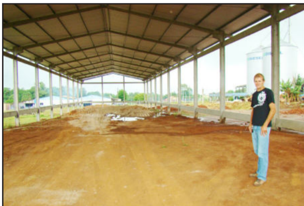
Paulo Renato Wermann junto ao novo pavilhão da Secretaria de Obras
