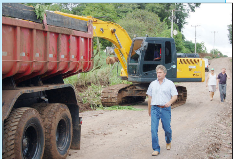
Prefeito Renato Airton Altmann (c) vistoriou o início das obras
