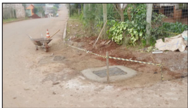
Bueiro foi fechado no Santo Antônio após solicitação da Defesa Civil
