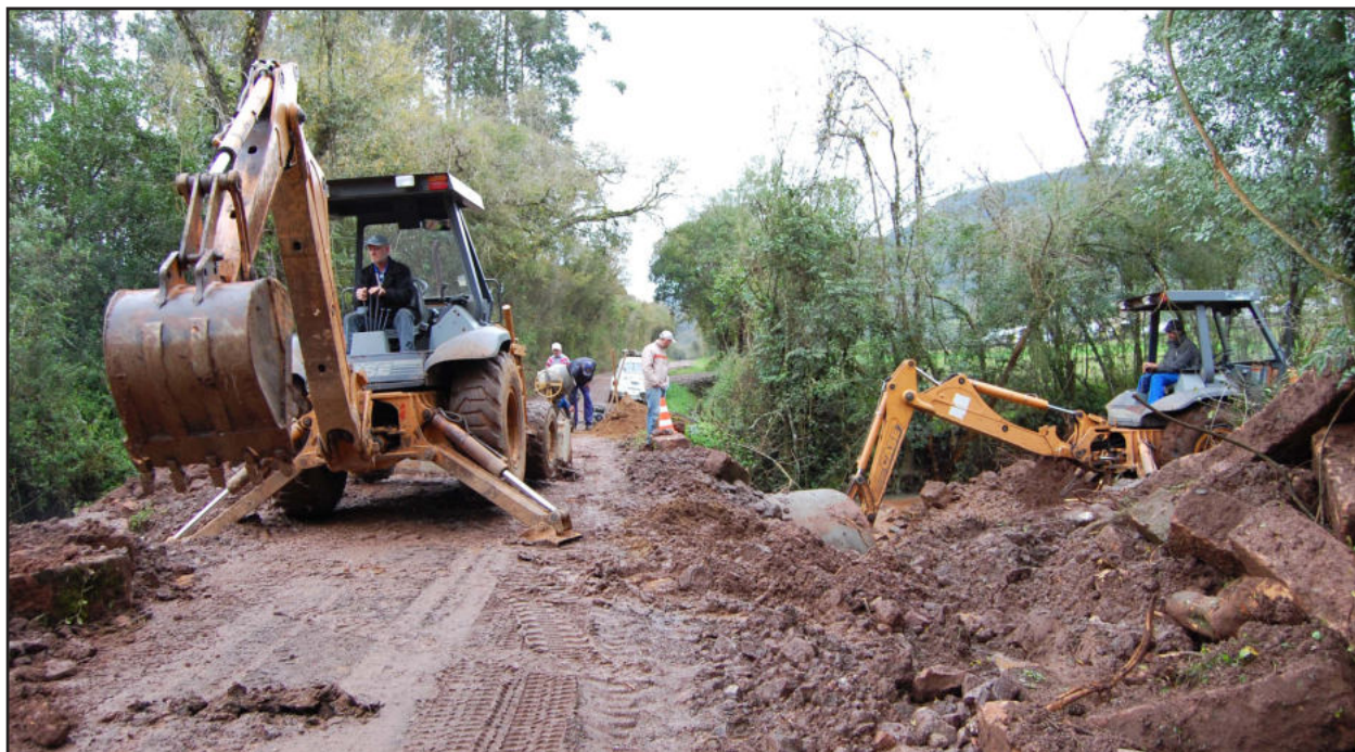
Equipe de Obras trabalhando na Linha Ernesto Alves
