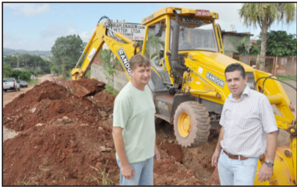
Lopes e Reis conferiram o início das obras na Rua Oswaldo Mathias Ely
