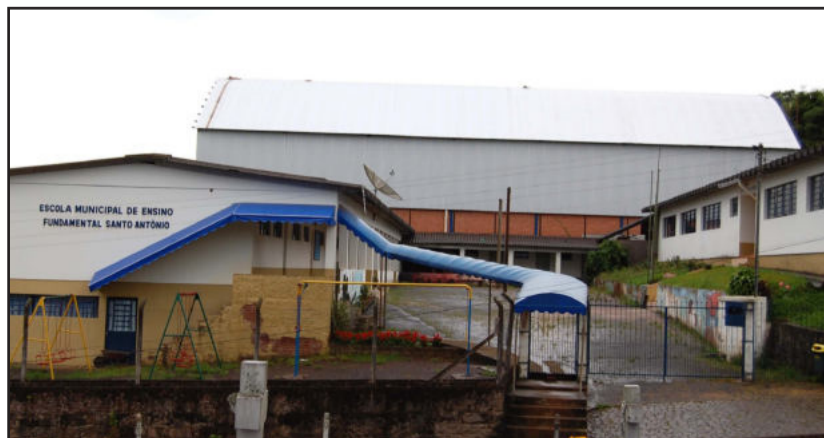
Quadra, ao fundo da escola, em fase de conclusão
