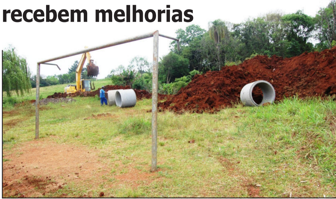
Canalização acabará com água parada e irá melhorar vazão
