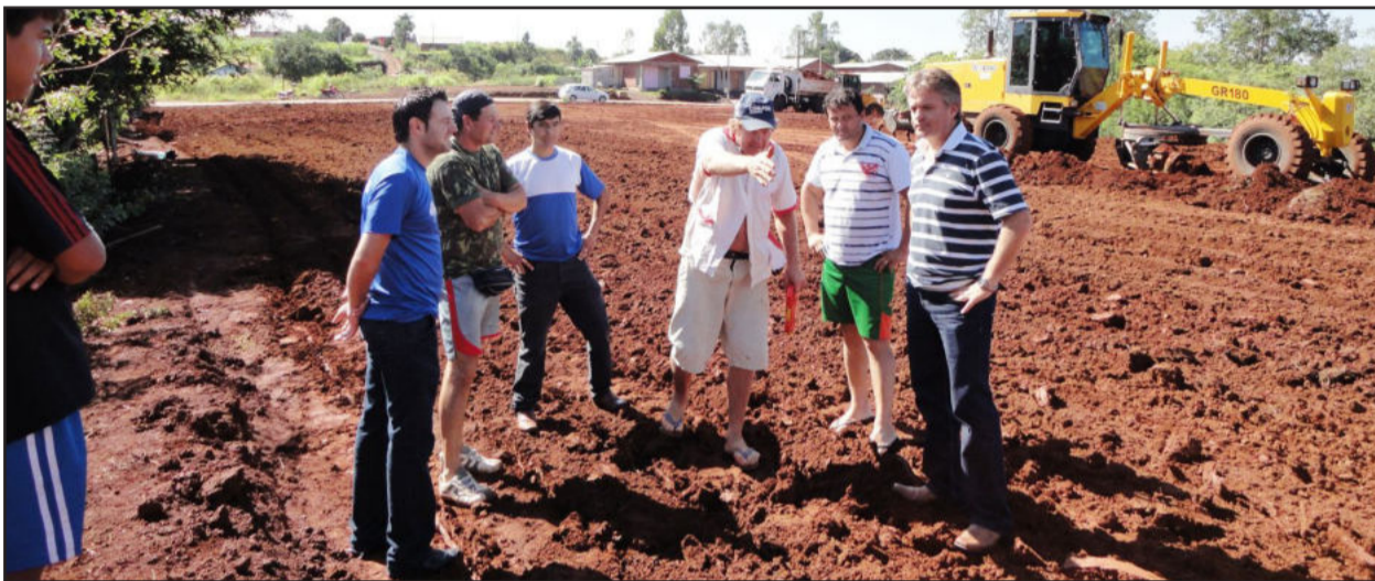
Prefeito e vereadores acompanharam máquinas trabalhando
