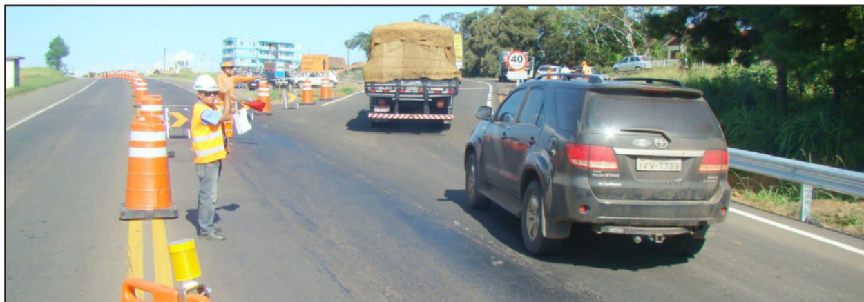
BR-386 desviada para a construção de elevada
