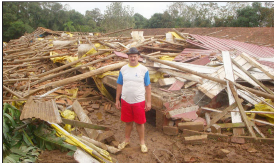
Oterno Sprandel diante do chiqueirão destruído pelo temporal
