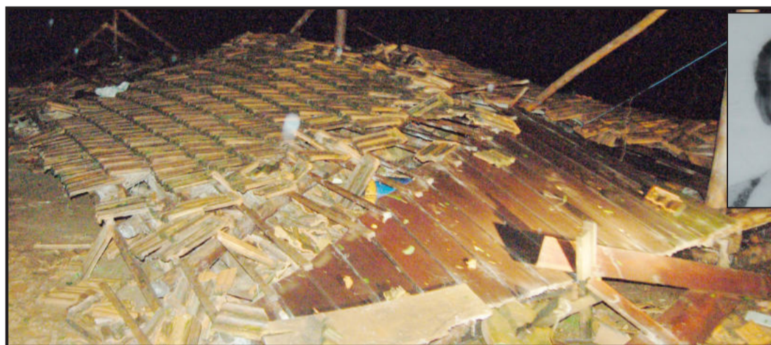
Morador foi atingido por construção que desabou
