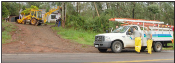
Equipes da AES Sul trabalharam em vários pontos
