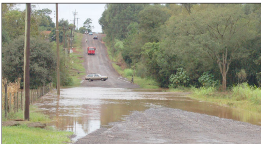
Água interrompeu estrada entre Cidade Baixa e o Centro de Paverama
