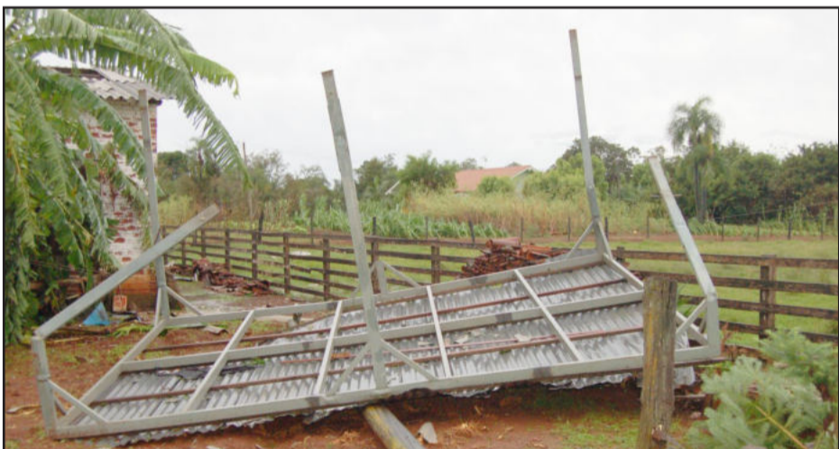
Portão de ferro da Fell Esquadrias, foi arrastado pelo vendaval
