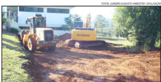
Obras iniciaram preparação do terreno na segunda-feira, dia 21 de maio
