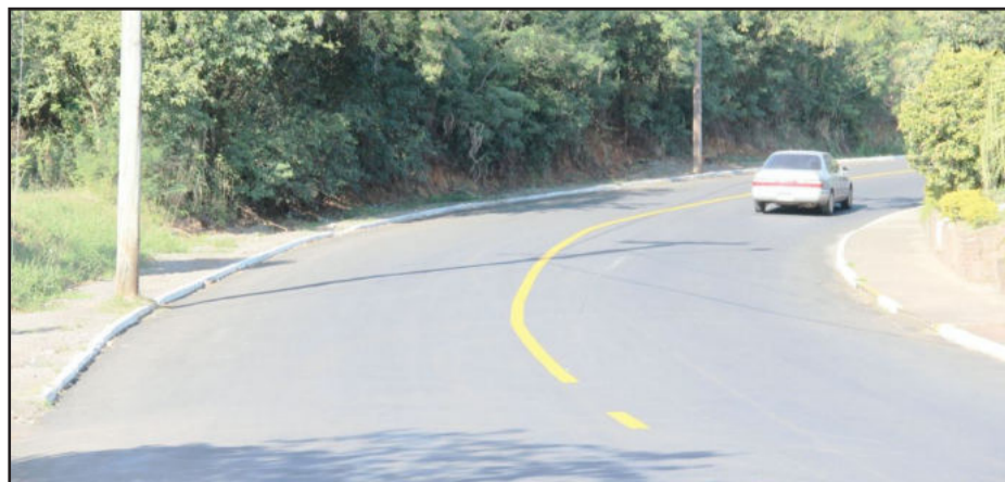
Equipe da SMDU ainda trabalha na Rua Geraldo Pereira
