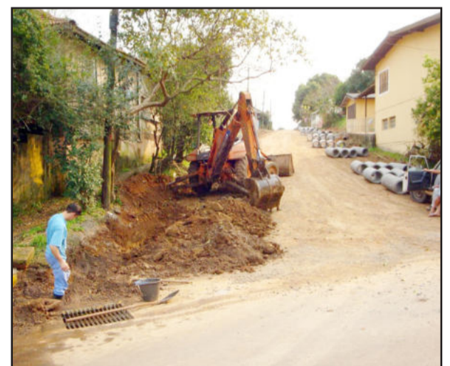
Pavimentação deve ser concluída até setembro
