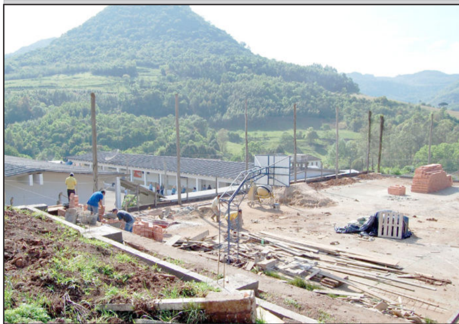
Obra de cobertura da quadra foi iniciada
