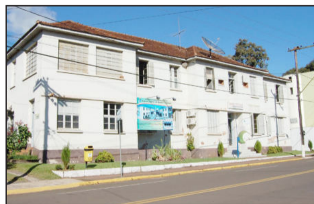
Antiga Policlínica está sendo readequada
