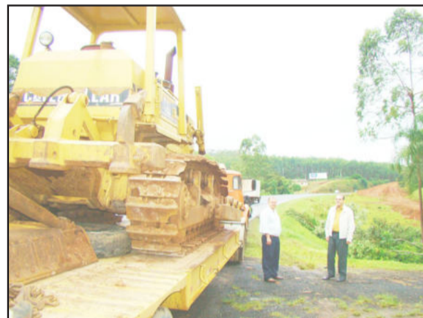
Dickel (e) e Fernandes acompanham início das obras de duplicação da BR-386
