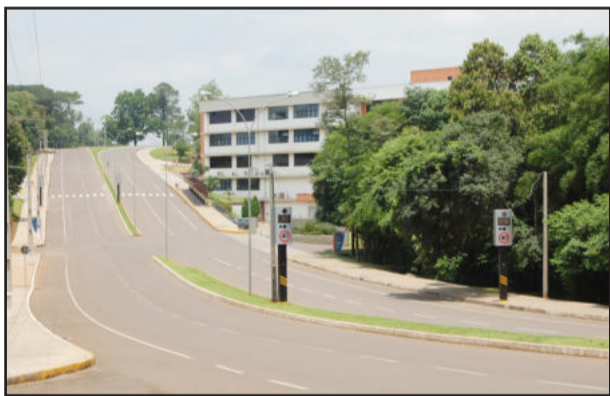
Lombada na Avenida Tallini
