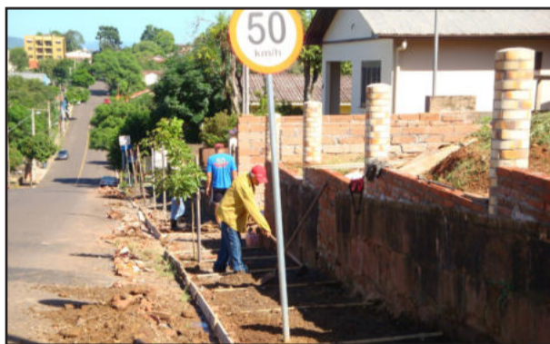
Rua Alfredo Matias Arenhardt tem calçada de passeio reconstruída
