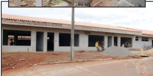
Construção da creche Mundo Encantado em Canabarro
