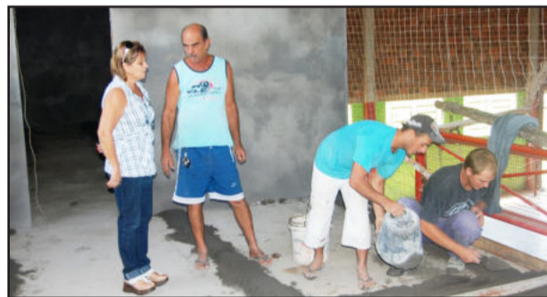
Secretária da Sthas, Nara Worm, confere início das obras do Telecentro
