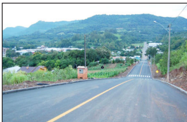
Pavimentação concluída na Rua Henrich Brachmeyer
