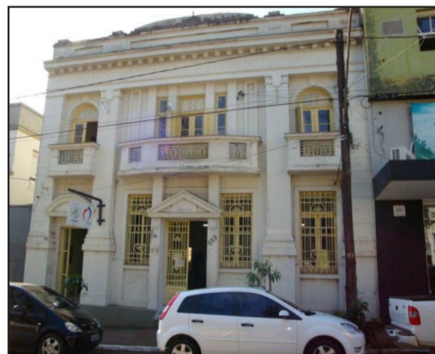
Prédio da nova sede do Detram
