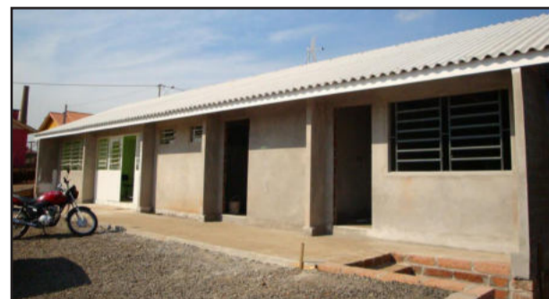
Nova sede da SMDU
