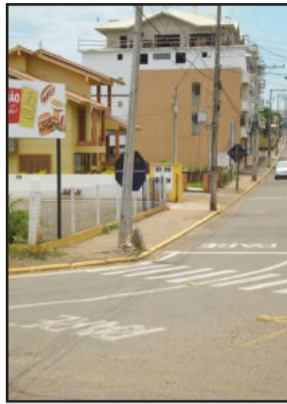
Poste original não foi substituído e segue quebrado
