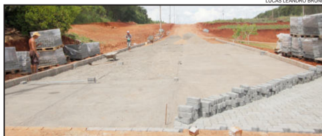
Pavimentação de trecho da Rua Mário Schaeffer é pré-requisito para Loteamento Morada do Sol
