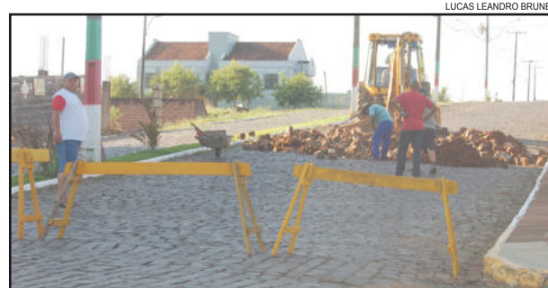
Município realiza obras de melhorias na Avenida 1 Leste, no trecho de paralelepípedo
