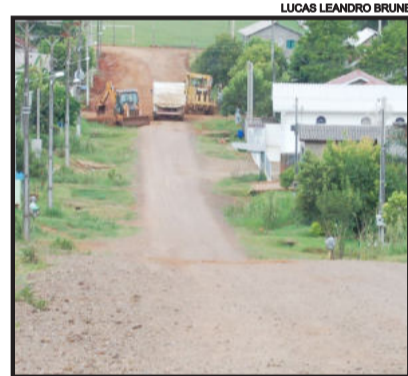
Iniciaram as obras para a pavimentação da Rua 16 de Abril, no Loteamento 8
