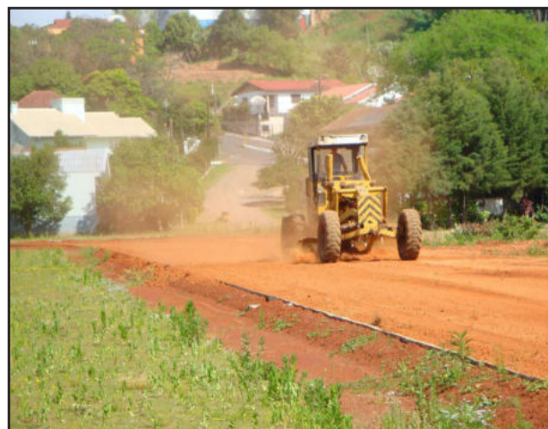
Obras continuam em ritmo acelerado no local
