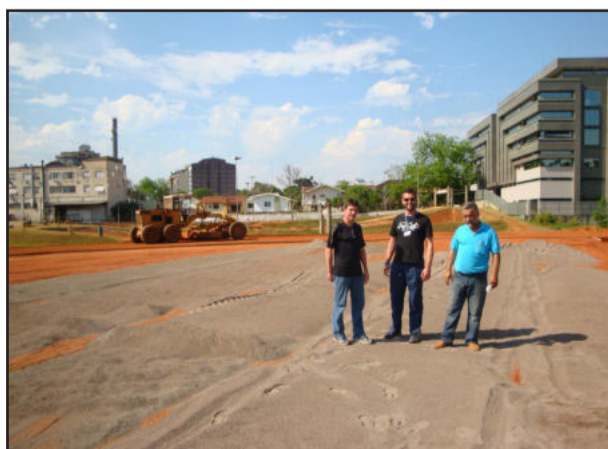
Nardir R. Steffens, Diego Konrad e Nardi A. da Silva acompanham as obras de infraestrutura
