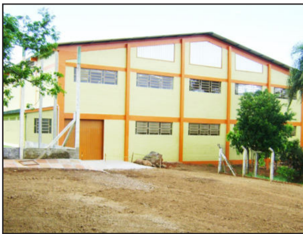
Detalhes finais e acabamentos estão sendo concluídos
