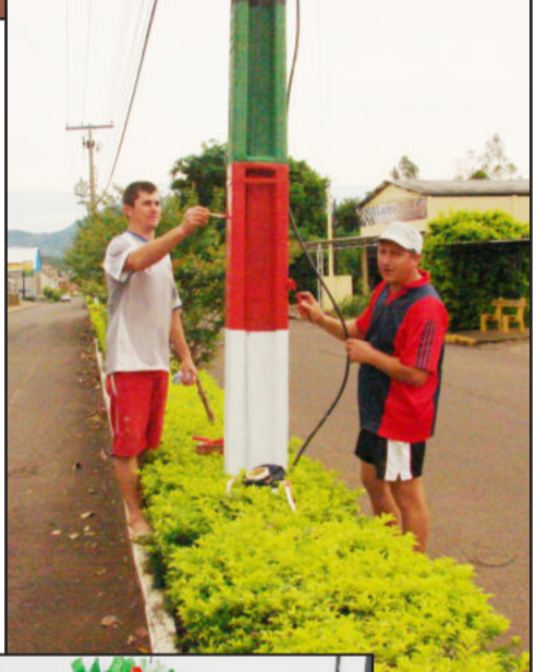
Pintura dos postes da Avenida 1 Leste
