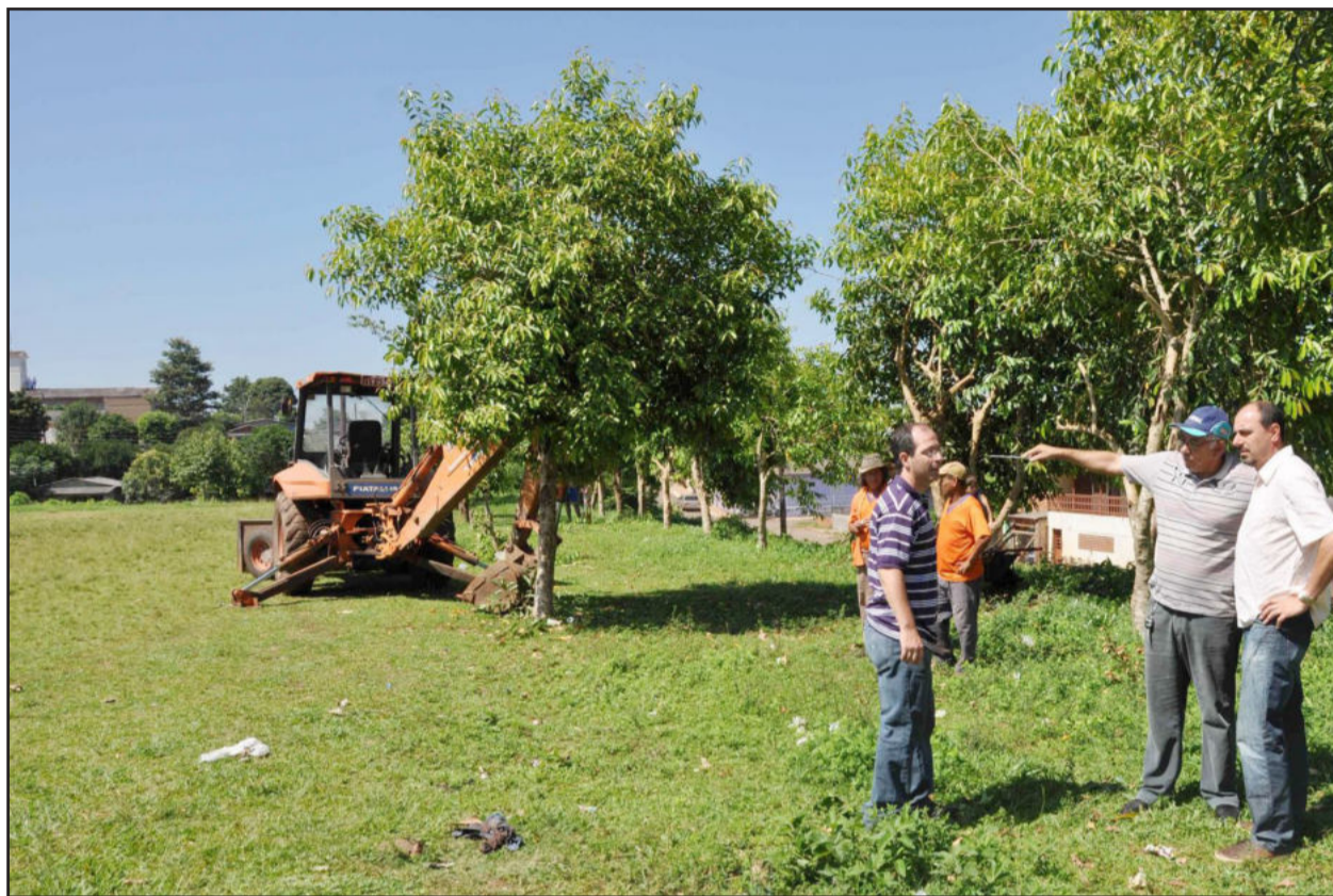
Os secretários Carlos Kayser e Isidoro Fornari acompanharam o início da obra
