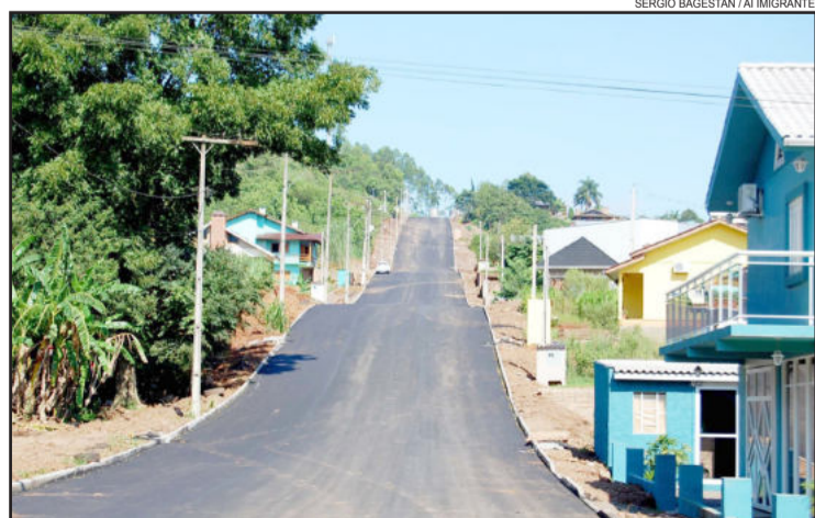
Pavimentação concluída na Rua Pastor Henrich Brackmeier
