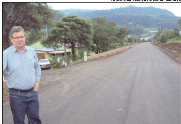
Obras concluídas na Schmidt Fundos
