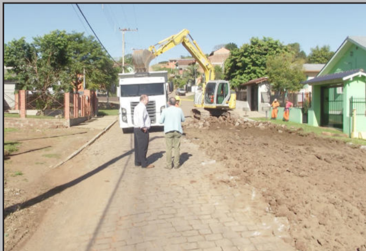
Obras para a construção do viaduto seguem em bom ritmo
