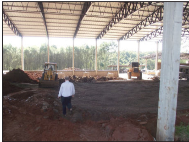
Máquinas trabalham na terraplenagem para a ampliação da indústria
