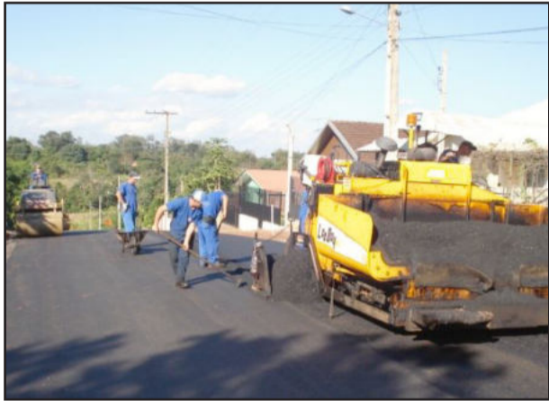
Rua Maria Olga Thomé, em Conventos, foi asfaltada
