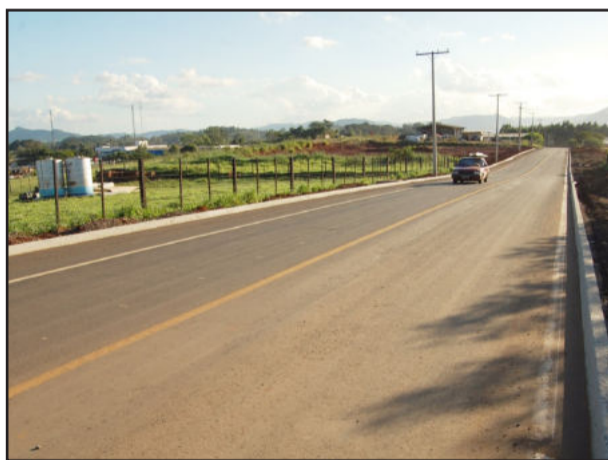
Asfaltamento da Rua Erly José Bach beneficiará empresários alocados no distrito industrial
