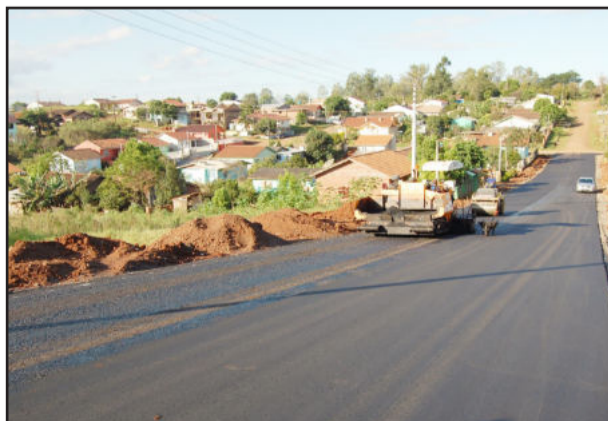
Asfaltamento da Rua Padre Nóbrega foi concluído
