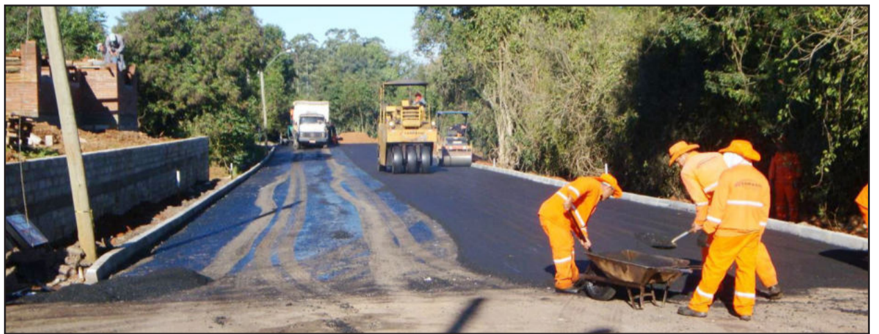
Trecho da rua Carlos Matte recebeu pavimentação asfáltica
