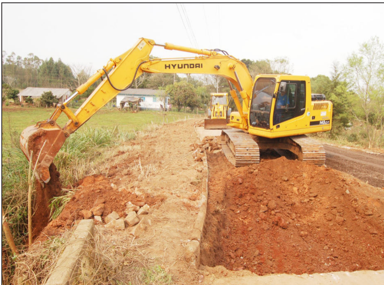
Primeira etapa das obras consiste na recuperação dos piores pontos e no nivelamento da pista
