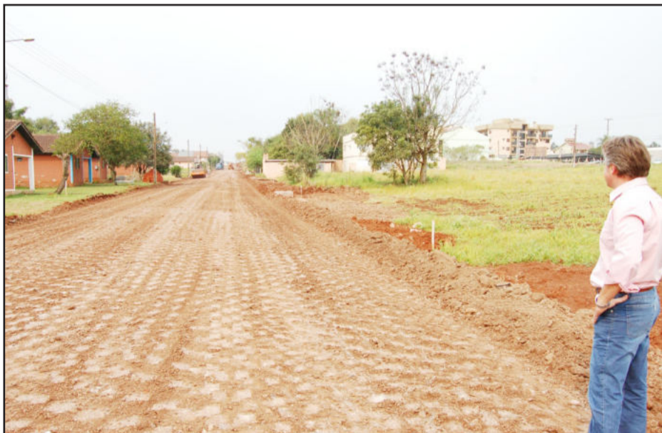
Prefeito Renato Altmann acompanhou o andamento das obras nesta semana
