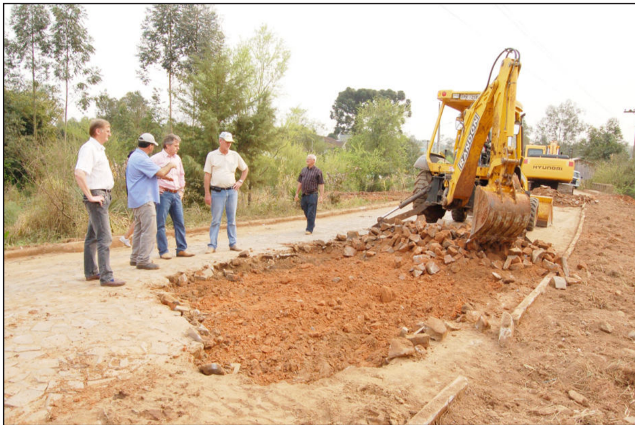
Administração Municipal deu início às obras de recuperação da Estrada de Posses
