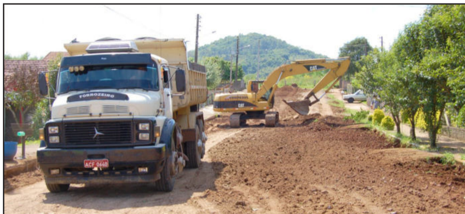
Preparação de ruas para a pavimentação
