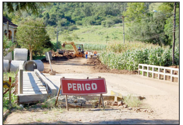
Rua Henrique Blum receberá pavimentação asfáltica
