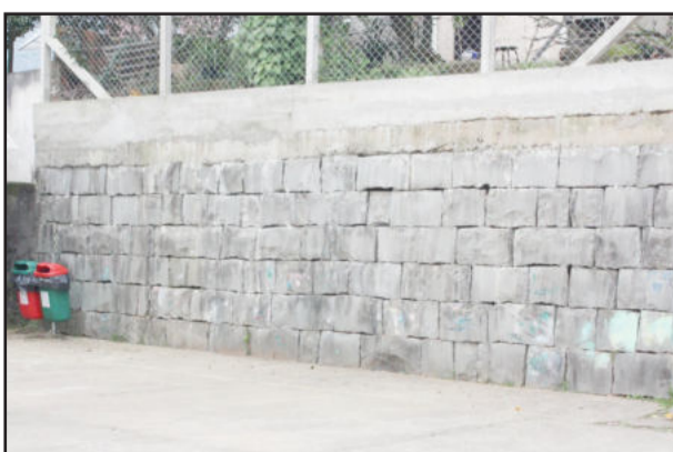
Muro protege quadra de esportes
