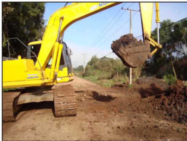
Preparação do leito da estrada
