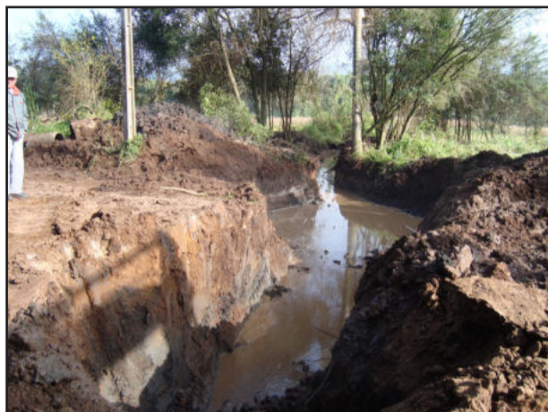
Obras de drenagem
