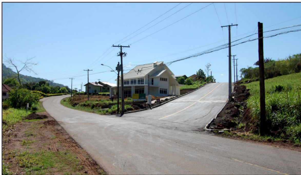
Novo acesso ao Centro de Imigrante valorizado com pavimentação asfáltica
