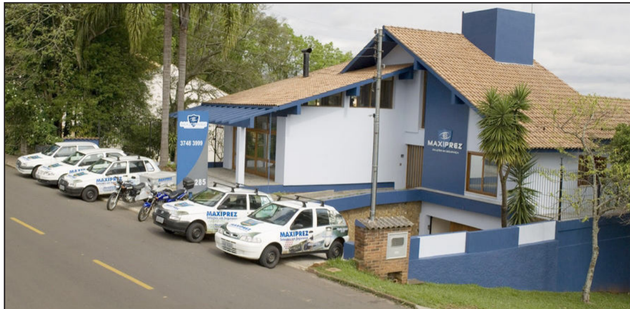
Nova sede própria da Maxiprez em Lajeado
