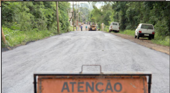
Pavimentação asfáltica da rua São Roque teve investimento de R$ 50 mil
