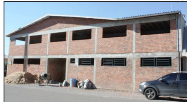
Iniciam obras da 2ª etapa do Ginásio do Bela Vista II
