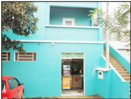
Prédio recebeu pintura interna e externa
