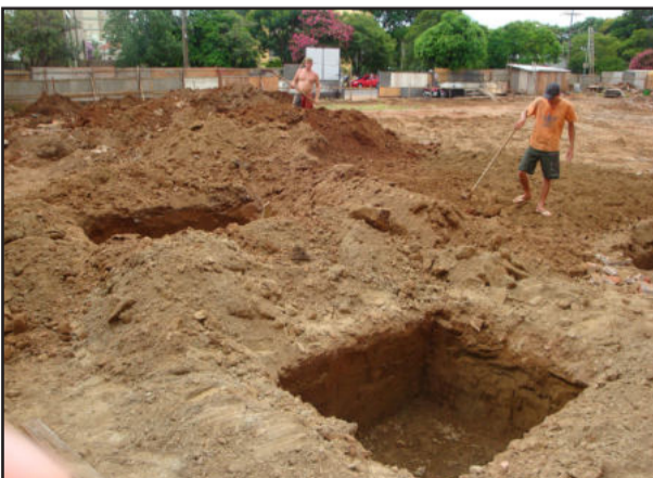
Preparação da área para as sapatas
