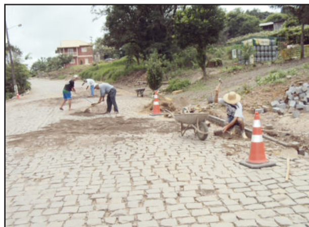
Calçamento está sendo recuperado
