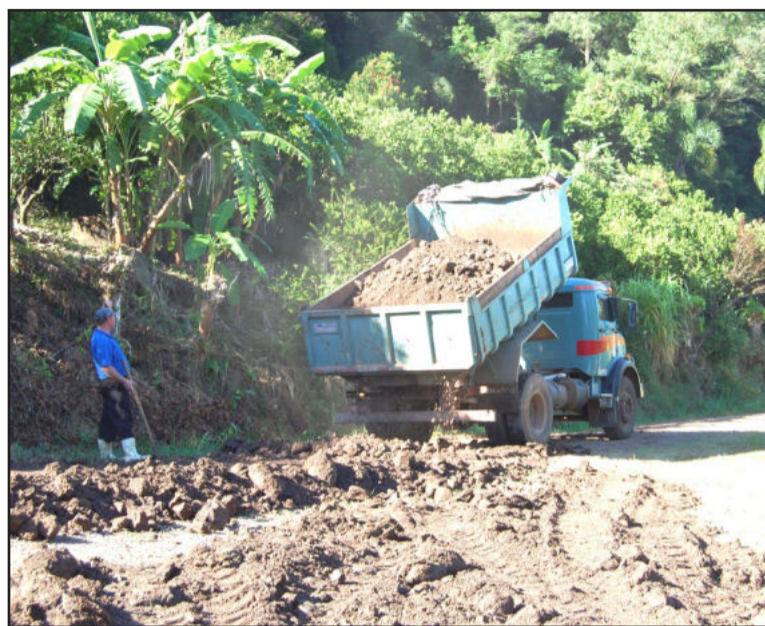
Colocação de saibro para melhorar a rodovia
