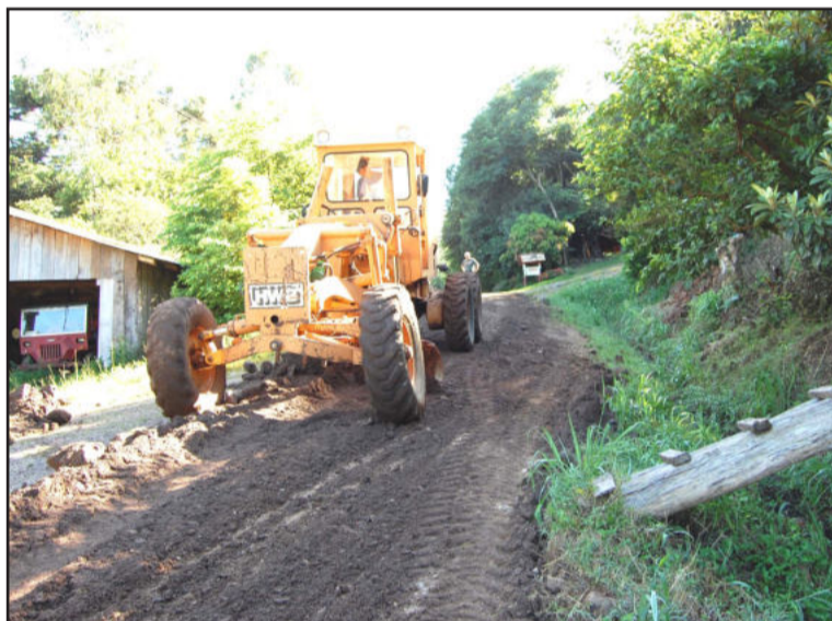
Motoniveladora recupera estrada do interior
