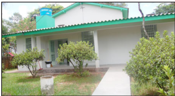
Prédio foi ampliado e reformado
