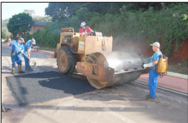
Operação tapa buracos recuperou vias de Lajeado, como a Avenida Amazonas
