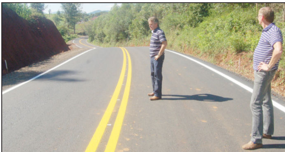
Asfaltamento e sinalização concluídos na Estrada das Posses
