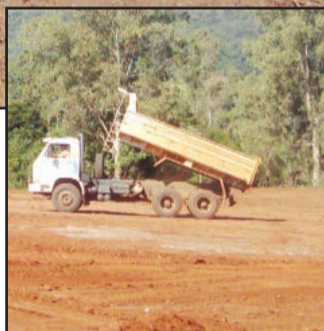
Terraplenagem para espaço de shows está em fase final
