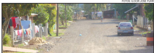
Ruas já receberam infraestrutura necessária para execução da pavimentação asfáltica
