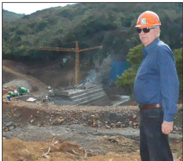
Egon Hoerlle acompanhou de perto as obras da nova hidrelétrica
