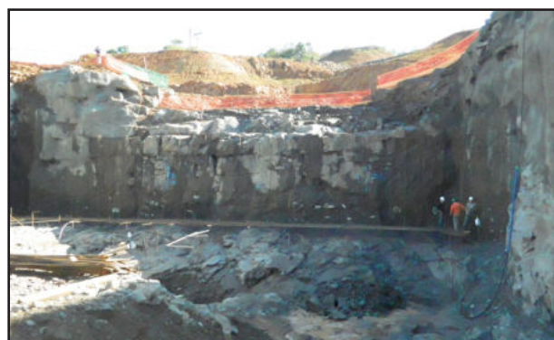
Em estágio inicial, local que abrigará a casa de máquinas da hidrelétrica
