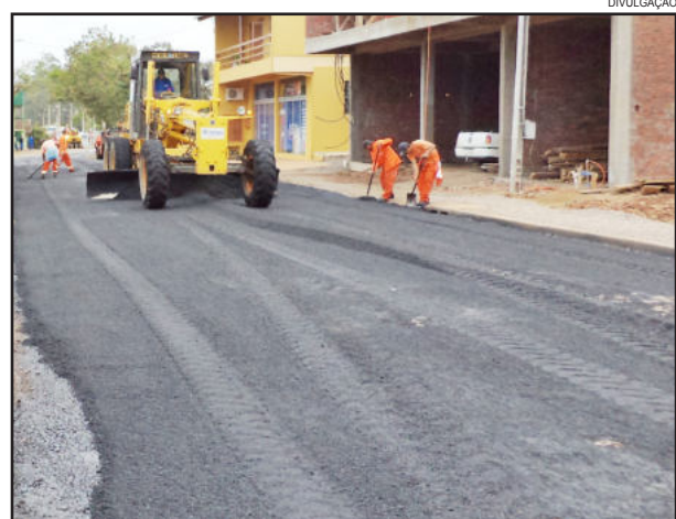
Camada asfáltica coloca fim nos buracos da rua
