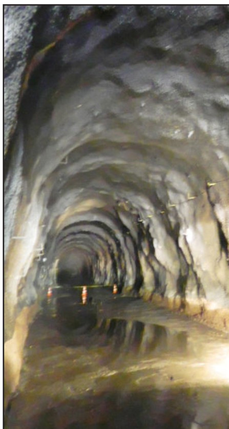
Túnel de adução terá quase 1 km de comprimento
