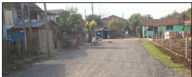
Ruas receberão pavimentação asfáltica
