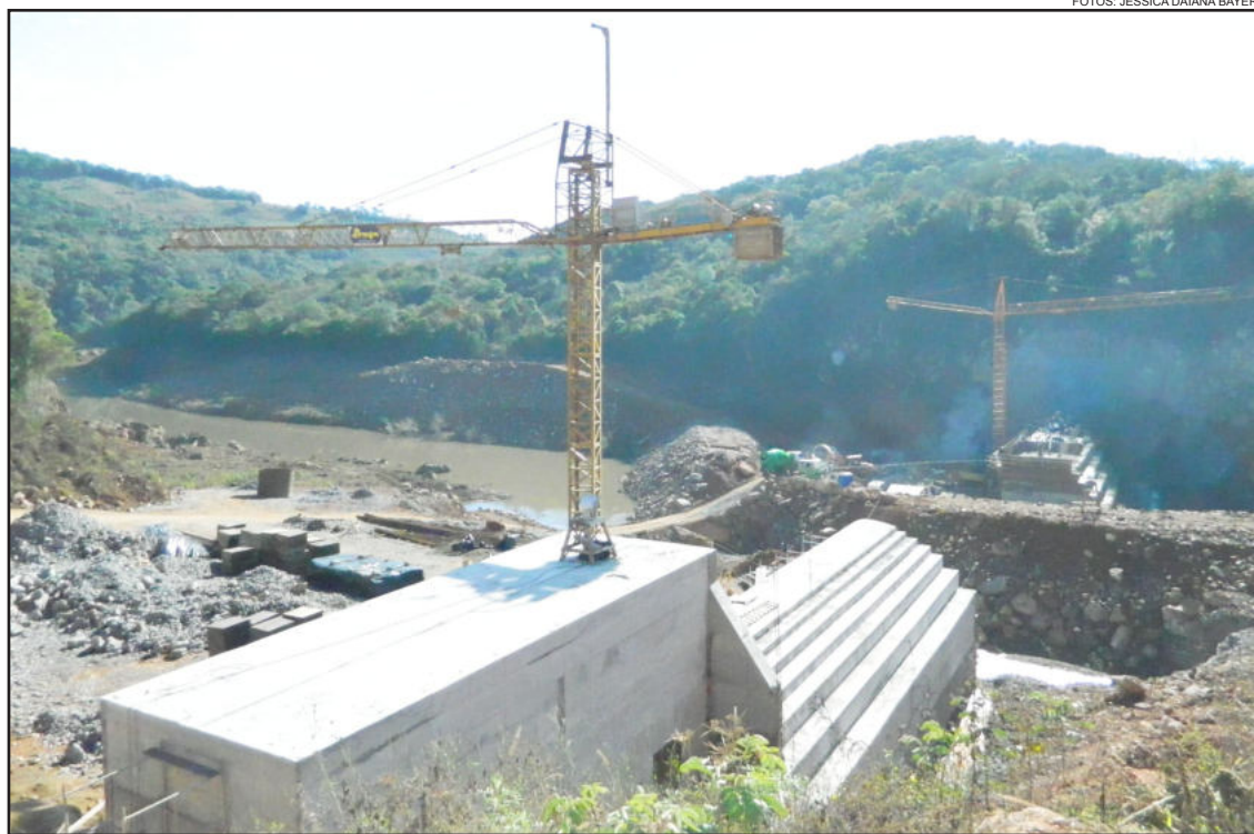
Barragem construída toda em concreto terá vazão de 1694,5 m³ por segundo
